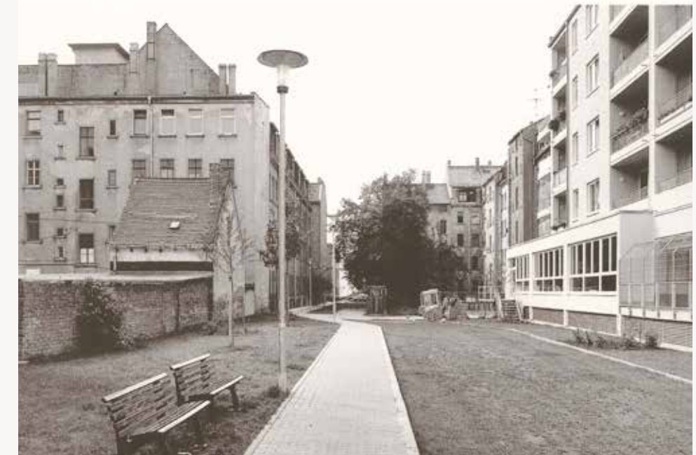
Zwischen Gleis- und Nonnenstraße, Leipzig, Plagwitz (Foto oben: 1990, Foto unten: 2014)
