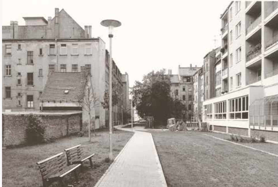
Zwischen Gleis- und Nonnenstraße, Leipzig, Plagwitz (Foto oben: 1990, Foto unten: 2014)
