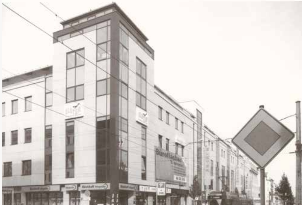
Zschochersche Straße/Lauchstädter Straße, Leipzig, Plagwitz (Foto oben: 1990, Foto unten: 2014)
